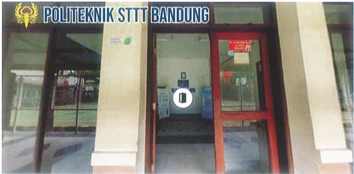
Gambar 25 Tampilan depan gedung C
